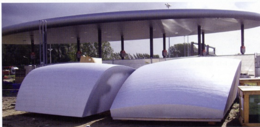
Twee met polyurea bespoten EPS-elementen liggen te wachten op montage.
