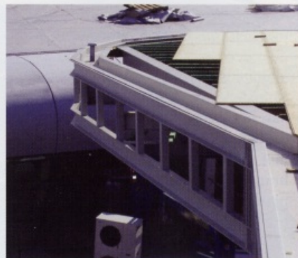
Detail opname van de achterconstructie van de dakranden van de luifel.
