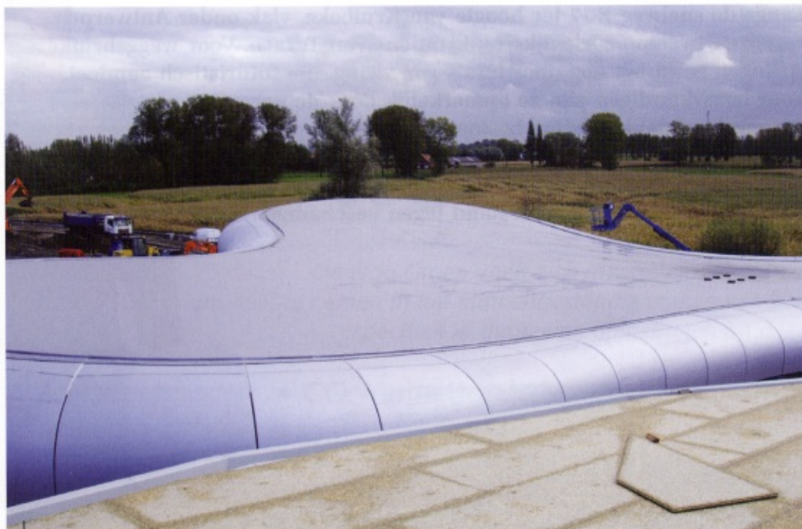
Niets aan de gevels en daken van de gebouwen is recht.
