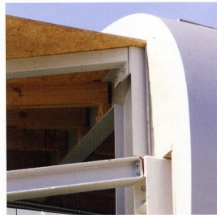
De geprefabriceerde, gefreesde EPS-elementen zijn tegen de staalconstructie gemonteerd.
