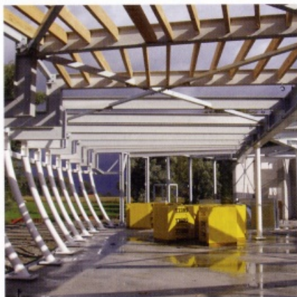
De stalen draagconstructie heeft in de gevelvlakken gekromde kolommen.
